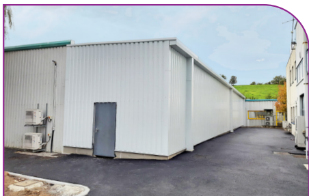
Construction d'un bâtiment pour l'extension du stockage de l'ESAT Didier Baron
