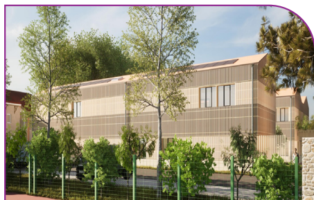
Démarrage du chantier pour la relocalisation à Genas de l'IME Le Grappillon et du SESSAD Saint-Exupéry
